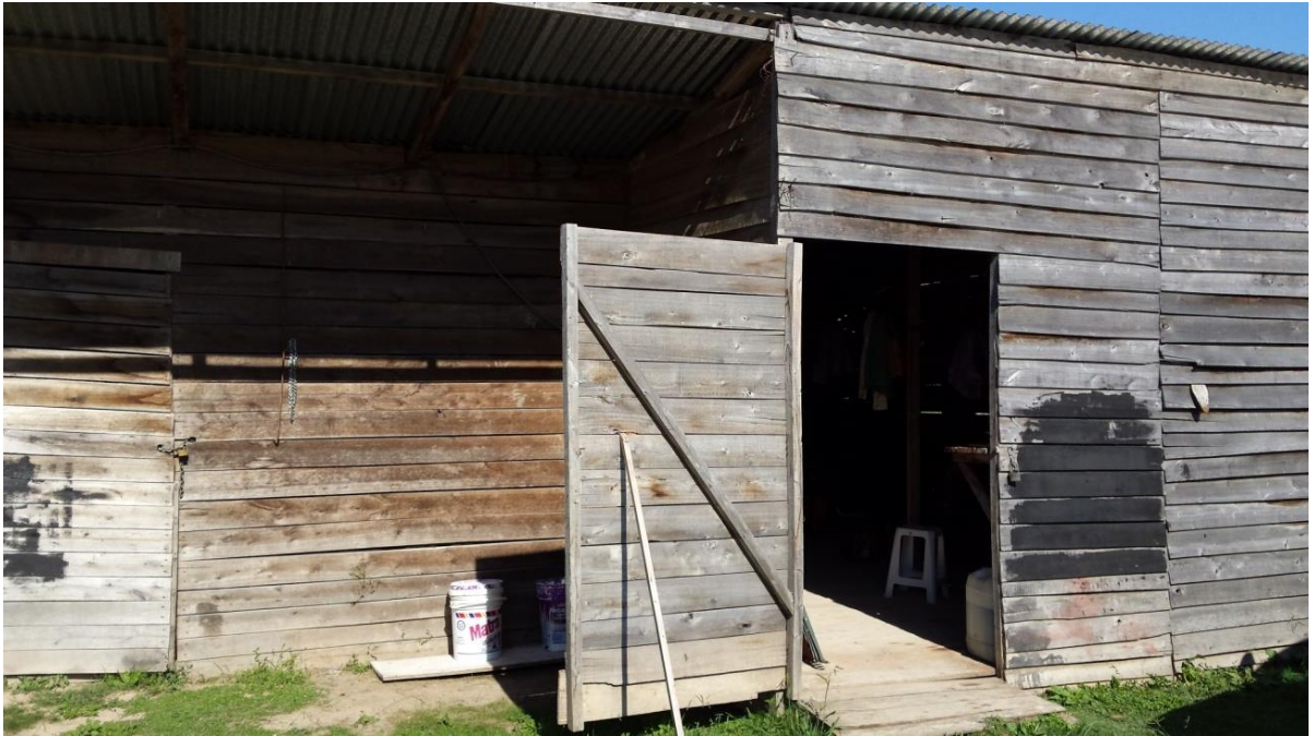
Obrador viejo, de herramientas, usado para la obra. PARA DEMOLER.
