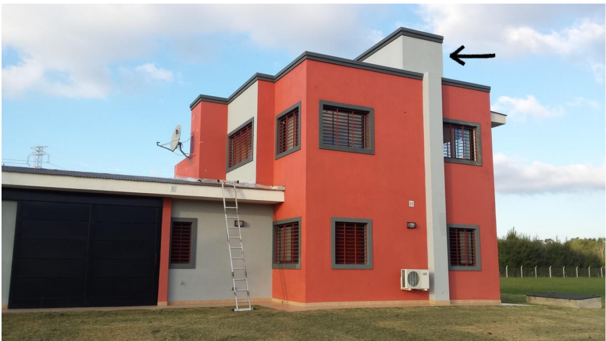
Ubicación de los Tanques de Agua.
