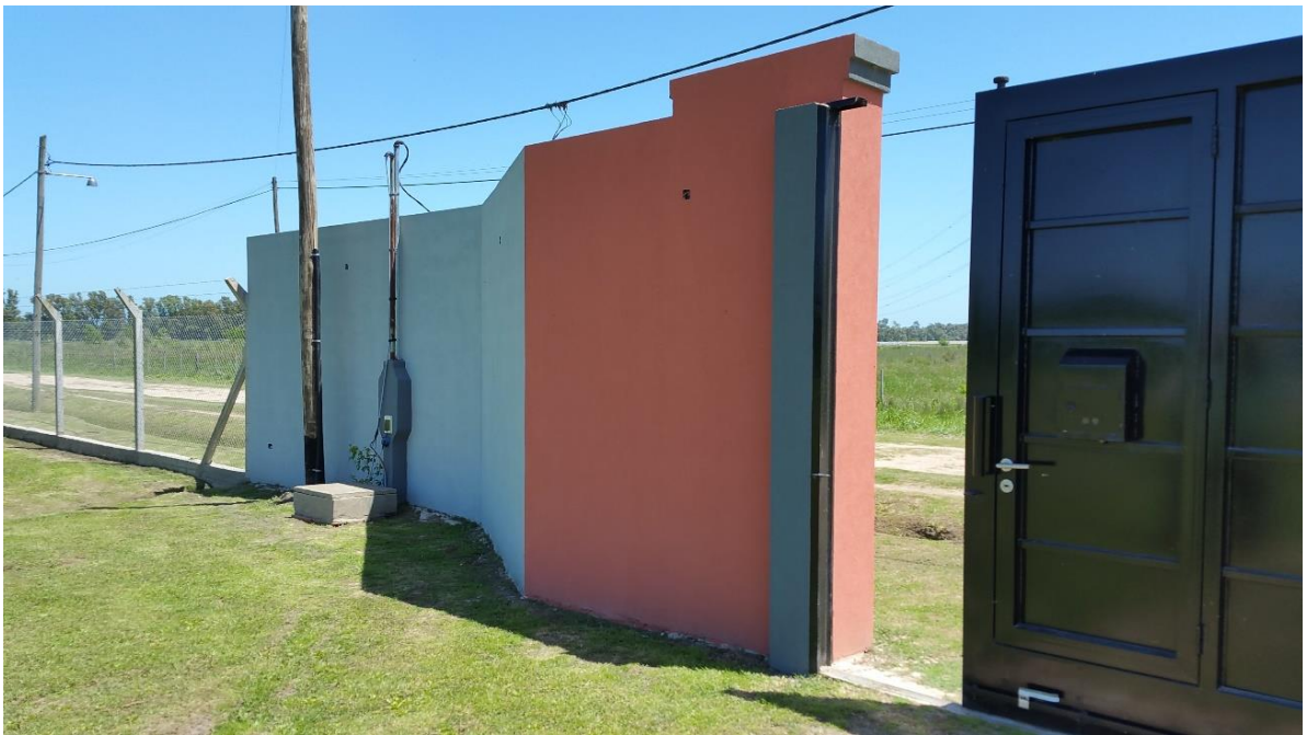
Portones con Motores corredizos a Control Remoto.
